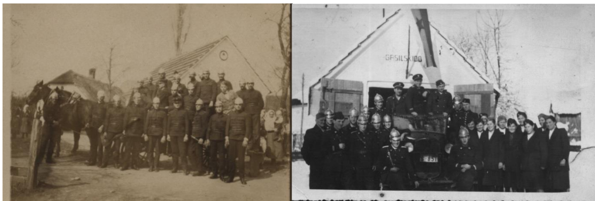
Slika 2: Drugi gasilski dom je bil postavljen na mejo med obema vasema.
